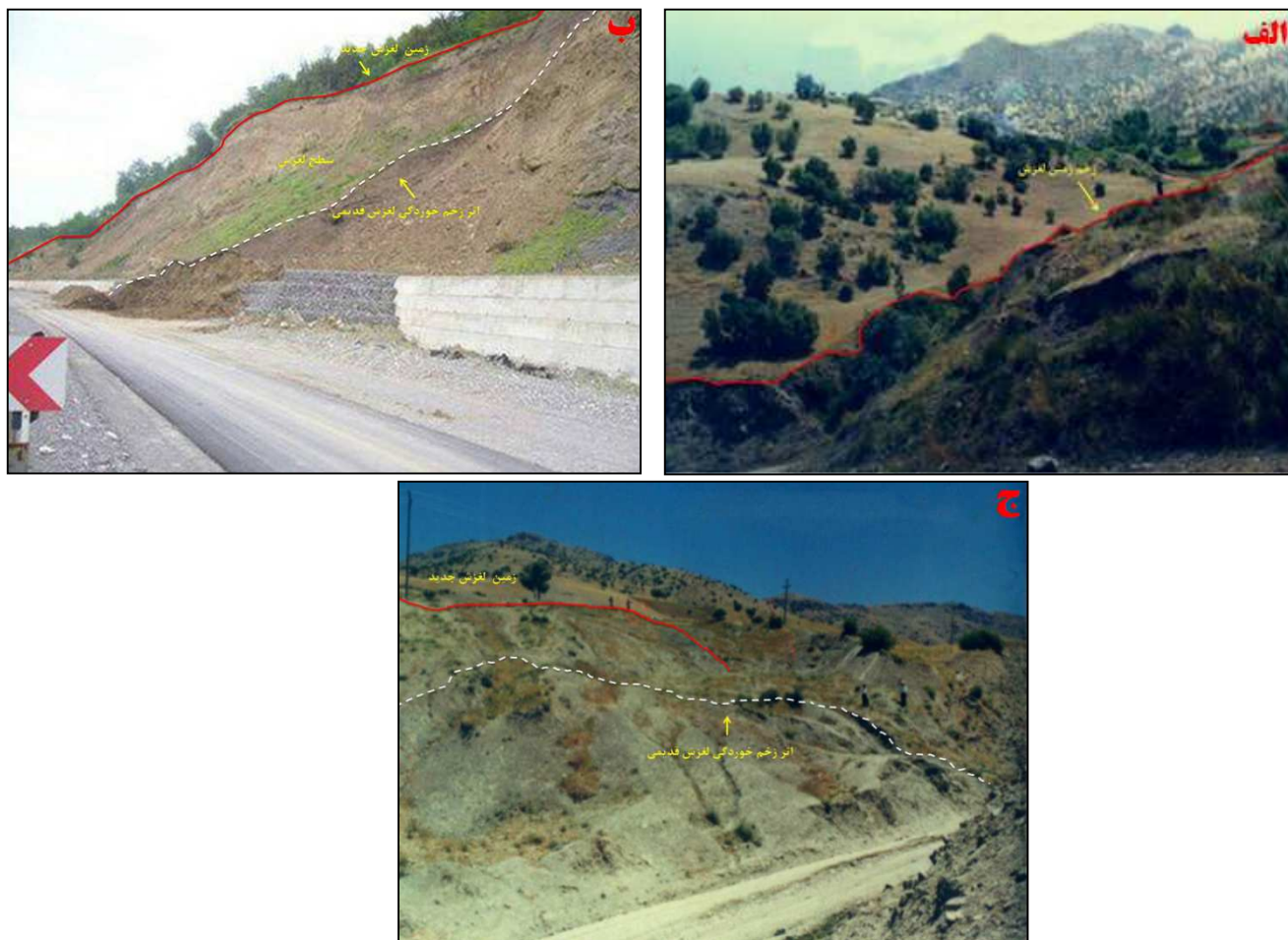
شکل ۳: تصاویری از زمین لغزش‌های منطقه مطالعاتی: (الف) زمین لغزش جنوب غرب پلنگان در شهرستان کامیاران، (ب) زمین لغزش دامنه غربی روستای ورمهنگ در شهرستان کامیاران، (ج) زمین لغزش شمال غرب یوزیدر در شهرستان کامیاران (منبع: نگارندگان)
