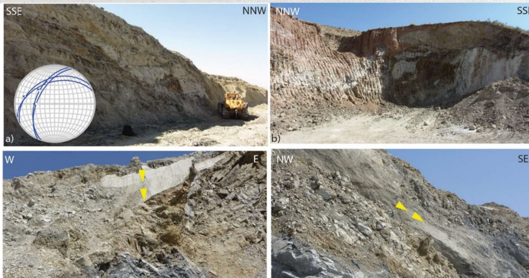
شکل ۱۱- a: سطوح لغزش نمودار نشانگر فرولغزش توده‌های خاک به سوی شمال غرب است. b: ترانشه دیواره اتوبان (در مجاورت نقاط a و b از شکل ۹) نشانگر مجموعه نهشته‌های ناهنجاری زمین لغزشی است. c و d: سطوح لغزشی در مجاورت نقطه دربردارنده خطواره‌هایی هستند که حرکت توده‌های ناهنجاری را به سوی جنوب نشان می‌دهند.
